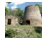
**Formentera à Montbolo** est l'arrivée de la voie ferrée de La Pinosa et des Ménérots. Un four à griller réduisait le minerai avant de l'acheminer jusqu'à la gare d'Amélie-les-Bains-Palalda.
