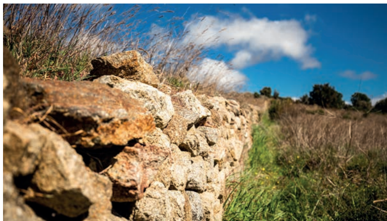
Muret en pierre sèche
