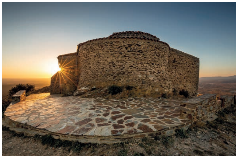
Les ruines de la tour à signaux du château de Força Real servirent à la construction de l'absidiole de la chapelle dédiée à Sainte-Marie.
