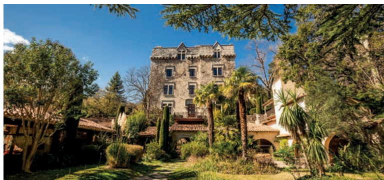
Molitg-les-Bains et son architecture thermique Belle Époque.
